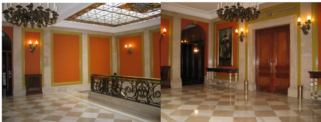
Pintura, rehabilitación de apliques y limpieza de vidrieras, hall del Salón de Plenos edificio Casa Consistorial.
