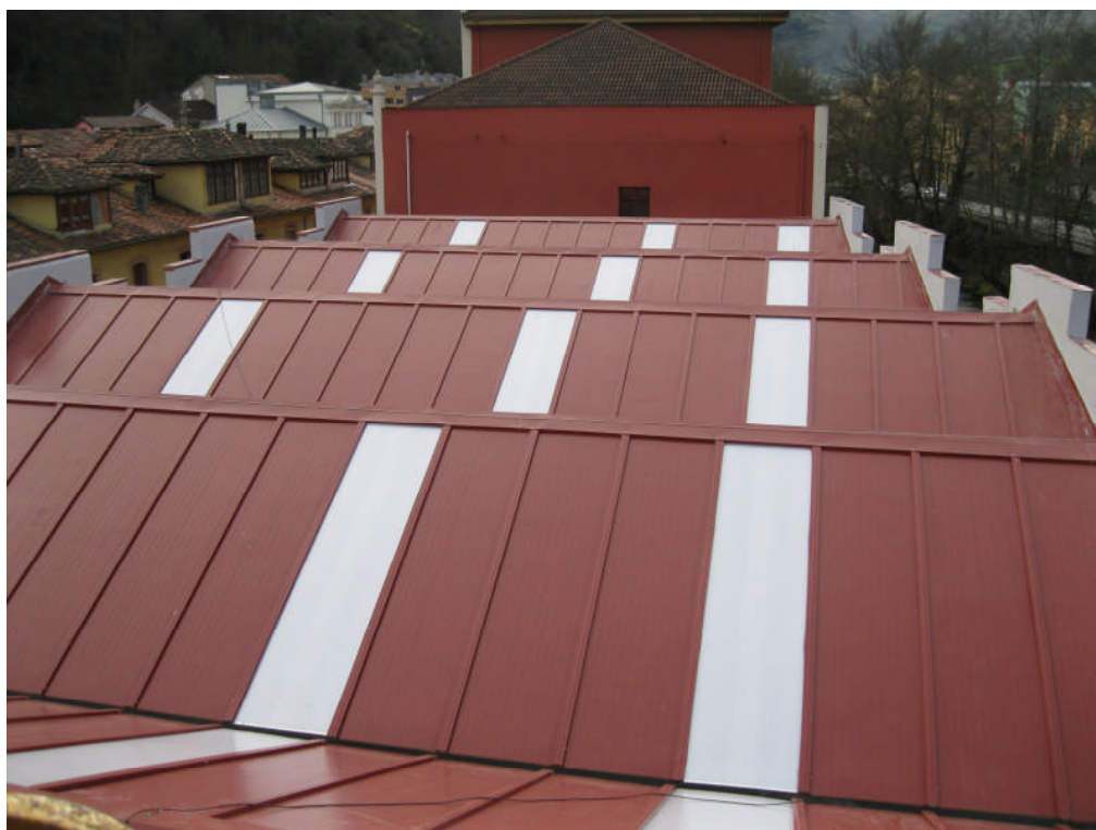
Sustitución general de cubierta del Polideportivo de Trubia
