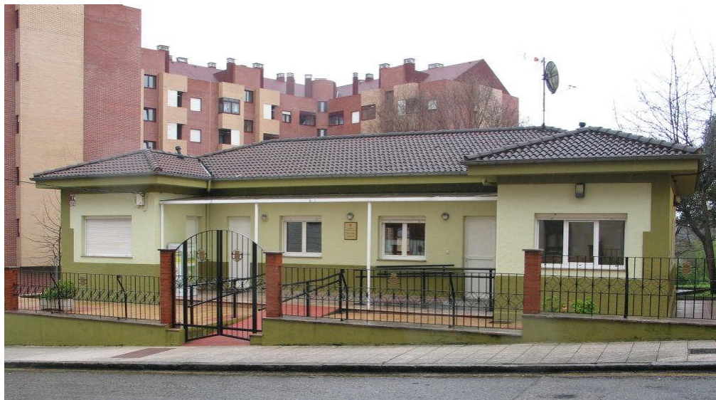
Pintura General interior y exterior del Centro Social Vetusta
