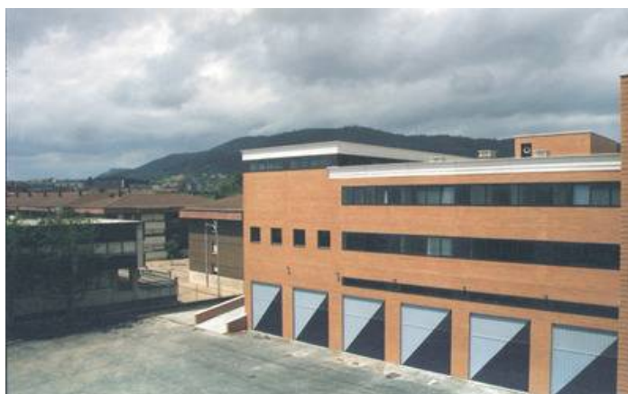
Edificio del Servicio de Extinción de Incendios
